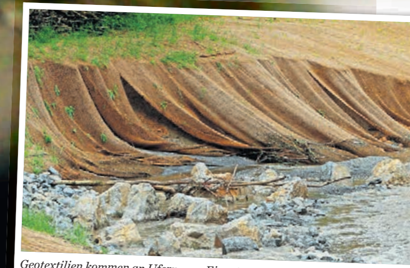
Geotextilien kommen an Ufern zum Einsatz.
