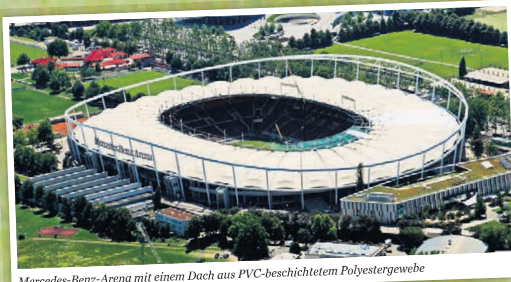
Mercedes-Benz-Arena mit einem Dach aus PVC-beschichtetem Polyestergerüst
